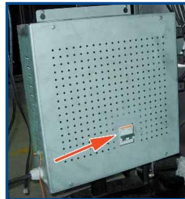
Figura 4.25 Magneto Térmico
