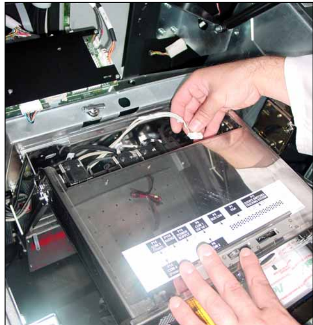
Figura 6.8.b Acceso a mangueras rack de control.
