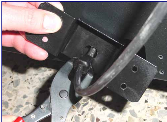
Figura 5.3.g Instalación del cable de red – paso 10.
