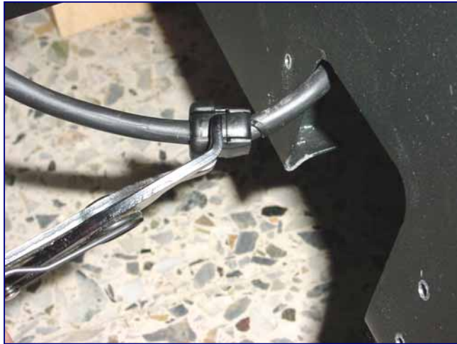
Figura 5.3.f Instalación del cable de red – paso 9.
