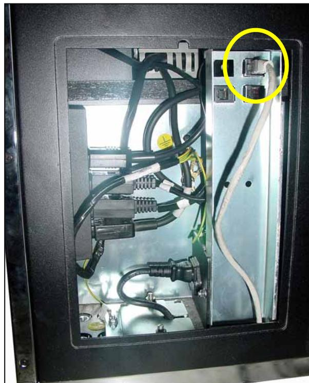
**Figura 4.3.j** Conexión ethernet.
