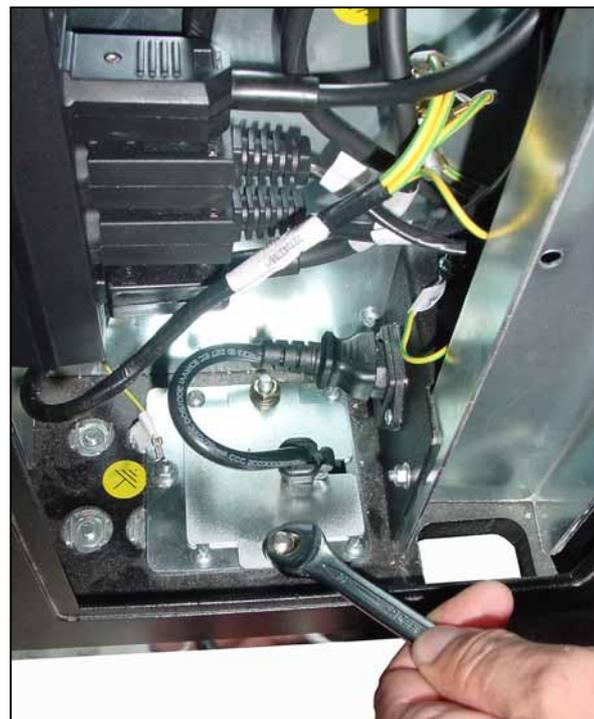
**Figura 4.3.h** Fijación de la tapa de salida del cable de red.
